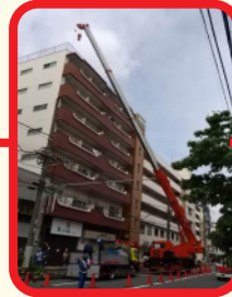
クレーンでの吊下ろし
